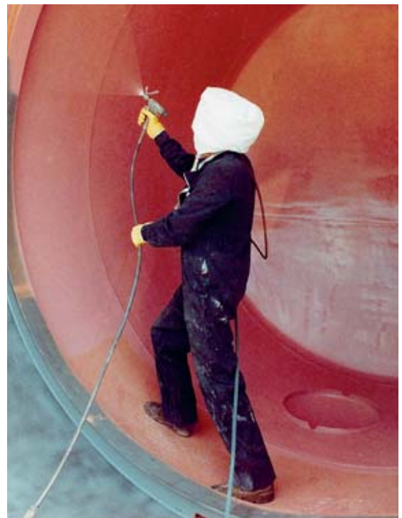
Fig. 6: le resine epossidiche sono una causa frequente di allergie cutanee. In caso di applicazione su una vasta superficie e soprattutto nei lavori di verniciatura a spruzzo, queste resine rilasciano vapori e aerosol che possono contaminare l'aria ambiente e scatenare un eczema. Per questo motivo è necessaria una protezione totale.
